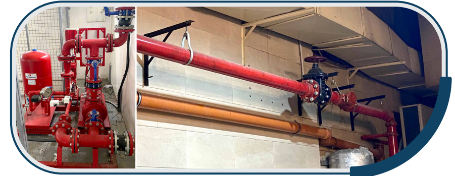
تمديدات خطوط الحريق (150 متر) Installation of fire fighting water pipes
