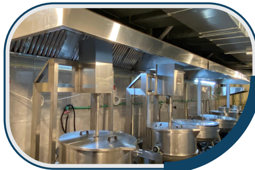
تجهيز شفاطات فوق طناجر الرز (4 مراوح شفط) Installation of hoods in the main kitchen
