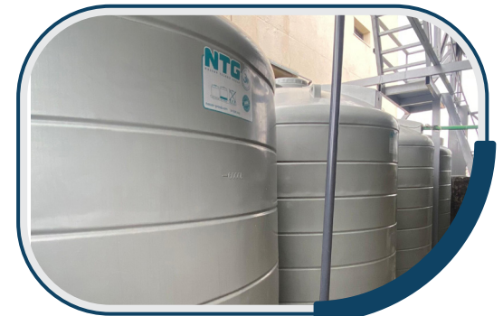
تجهيز خزانات المياه للحريق (60 م 3 ) Installation of water tanks for fire fighting
