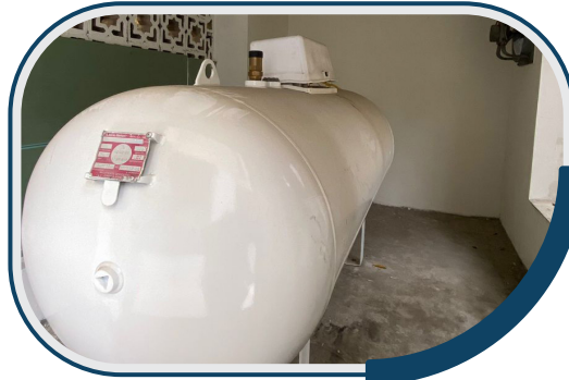
تركيب خزان الغاز للطبخ (1000 لتر) Industrial gas distribution tank
