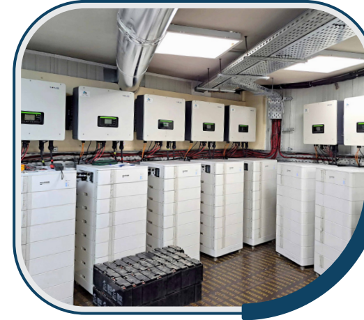
زيادة سعة البطاريات من 35 إلى 49 بطارية / من 87.5 إلى 122.5 كيلو واط ساعة Increasing battery capacity From 35 to 49 batteries / from 87.5 to 122.5 KWh
